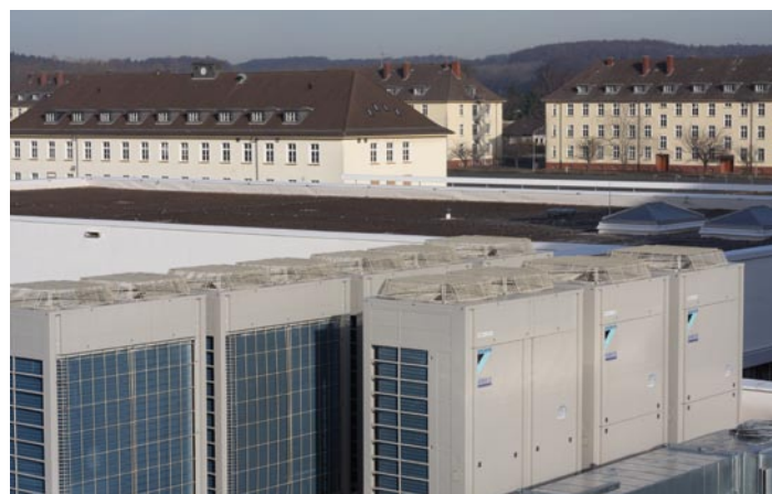
Insgesamt 70 Büros, Schulungs- und Besprechungsräume auf vier Etagen werden von sieben VRV-Systemen mit insgesamt 94 PS und einer Gesamtkälteleistung von ca. 263,4 kW klimatisiert
